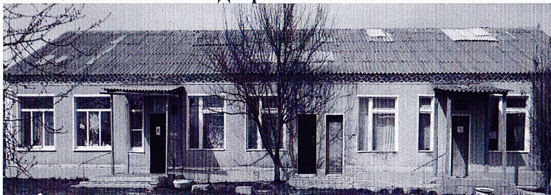
Состояние объекта «До» ремонта
